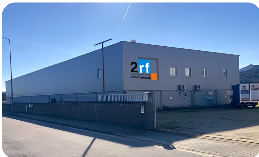
Armazém 2 - Zona Industrial de Queirã – Vouzela
