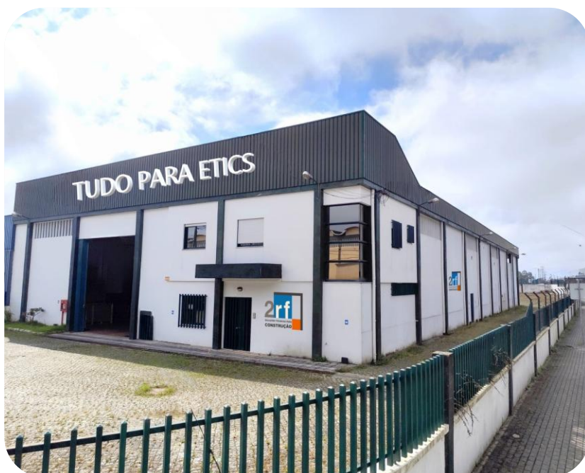
Armazém 3 – Zona Industrial da Silveirinha – São João de Ver
